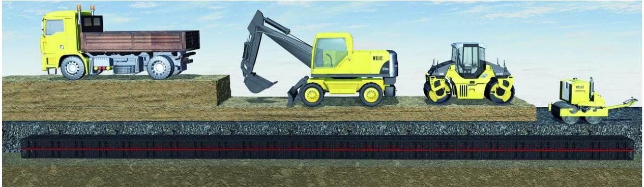
Während der Verfüllung der Baugruben können unterschiedliche Baugeräte verwendet werden. Das direkte Befahren der Rigolenelemente mit Verdichtungsgeräten sowie das Befahren von Verdichtungsgeräten mit eingeschalteten Vibrationsmotoren sind auf Grund der zusätzlichen dynamischen Lasten nicht zulässig.
