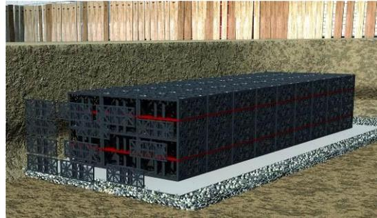
Nach Positionierung aller Blöcke wird die Anlage komplett mit Geotextil eingeschlagen. Das Geotextil verhindert den Eintrag von Schmutzpartikeln durch das Verfüllmaterial in das Versickerungssystem.
