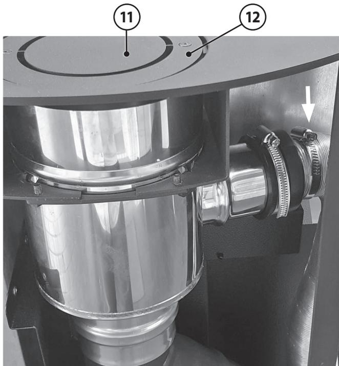
Die gelöste Schlauchschelle wird im Anschluss für die Befestigung des Alu-Flexschlauches an dem montierten Anschlussstutzen benötigt.
